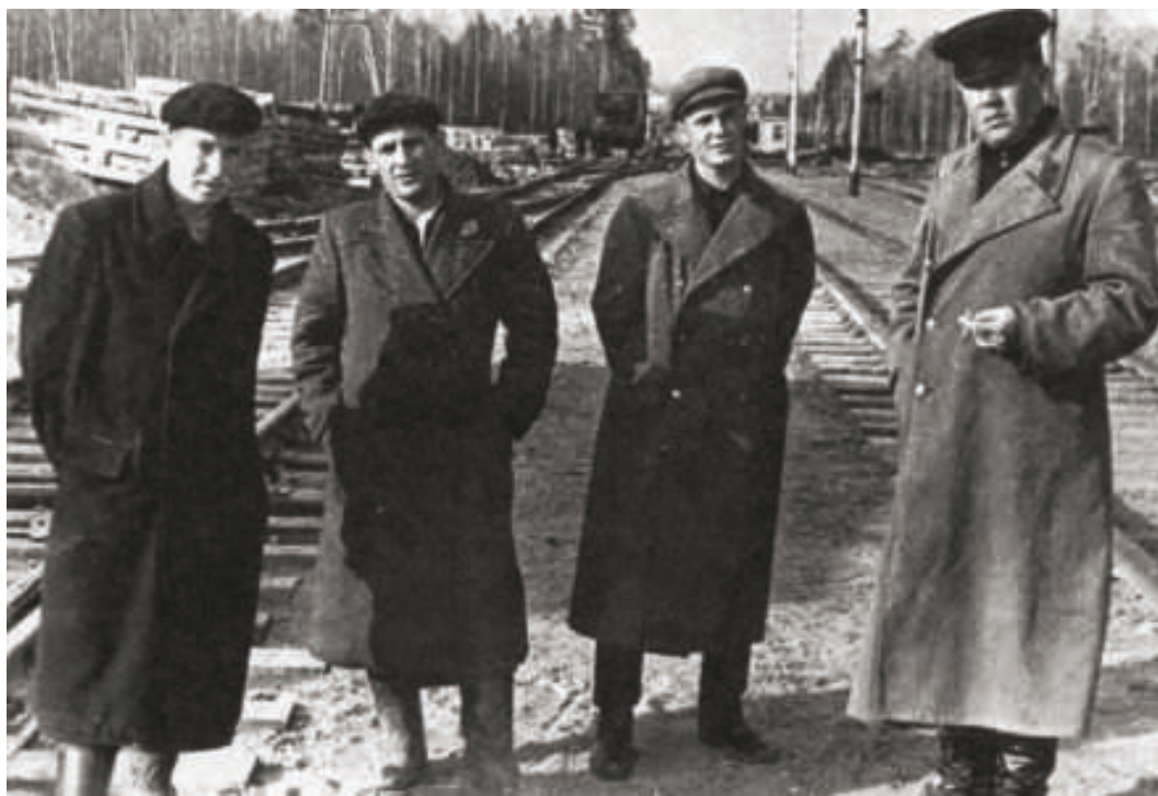
Строительство железнодорожной станции «Строительная» (слева направо: Ульянов И., Пронченко М., Анисимов А., Смольников В.), 1956 год
