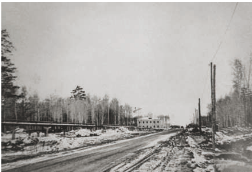
Автодорога на промплощадку № 1 и теплотрасса, 1958 год
