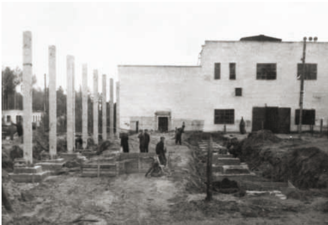
Строительство ремонтно-механического завода, 1957 год
