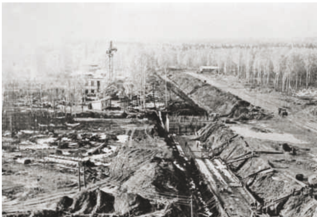
Строительство вентиляционного центра (слева — спецпрачечная)
