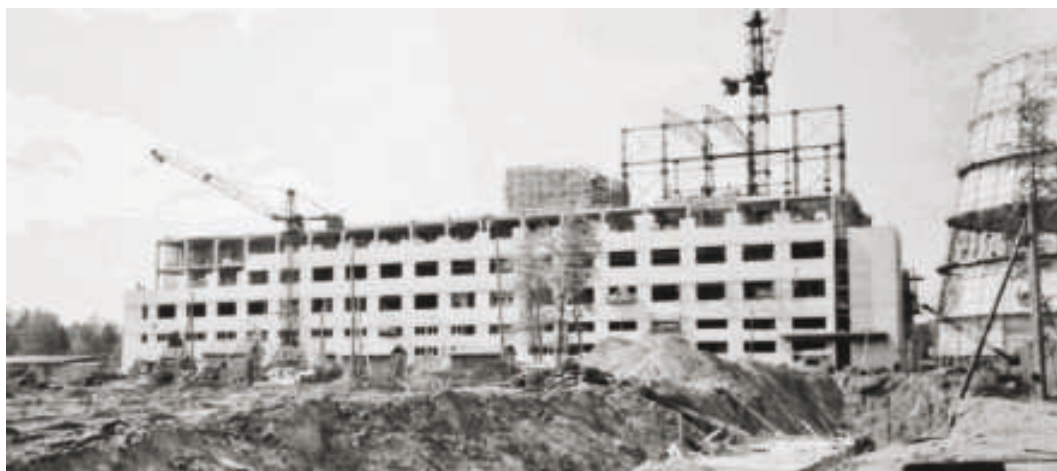
Строительство здания реактора ВК-50
