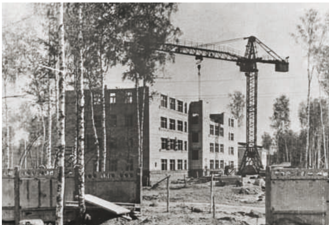
Строительство здания управления
