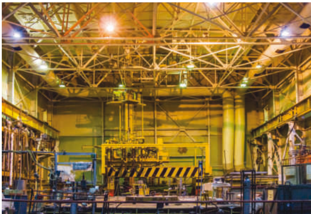
Центральный зал реакторной установки БОР-60
