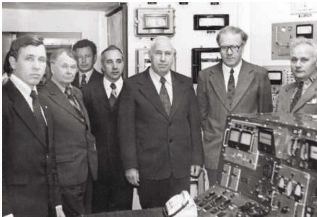
Директор института Цыканов В.А. и главный инженер Демьянович М.А. при пуске атомной станции теплоснабжения
