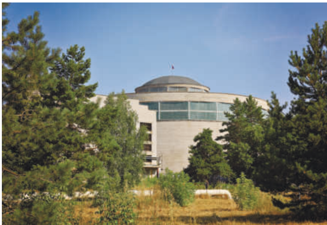
Здание реакторной установки МИР
