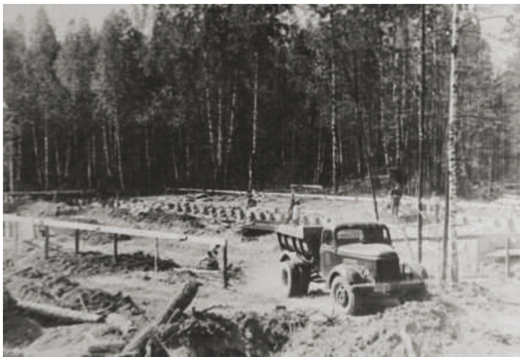
Закладка фундамента здания здравпункта
