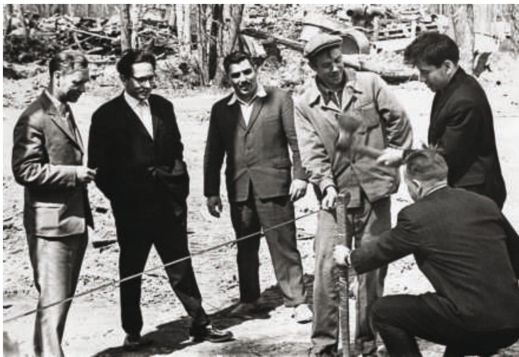
Закладка первого межевого знака при строительстве здания реактора БОР-60
