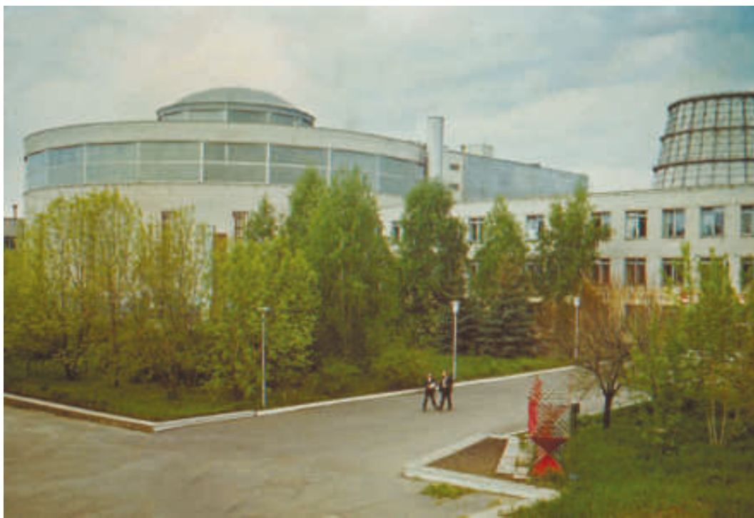
Здание реакторной установки МИР
