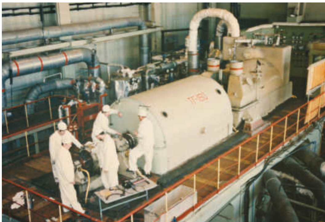
Профилактические работы на турбо- генераторе реакторной установки БОР-60
