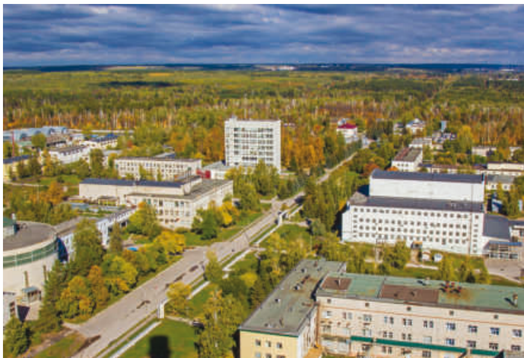
Панорамный вид территории промплощадки № 1
