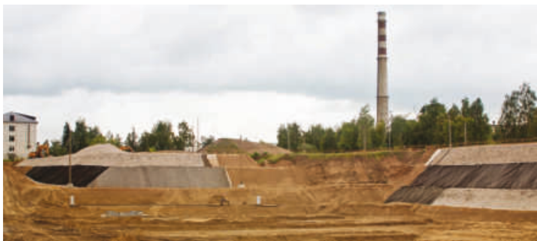
Строительная площадка реактора МБИР, 2015 год
