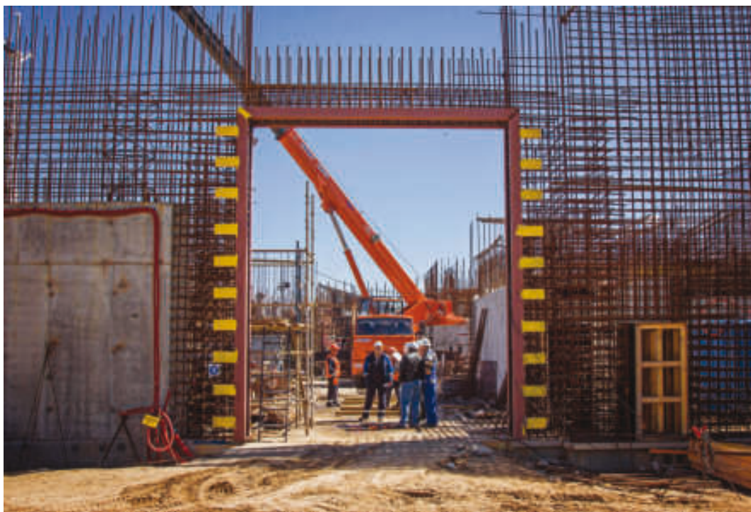
На строительной площадке полифункционального исследовательского радиохимического комплекса
