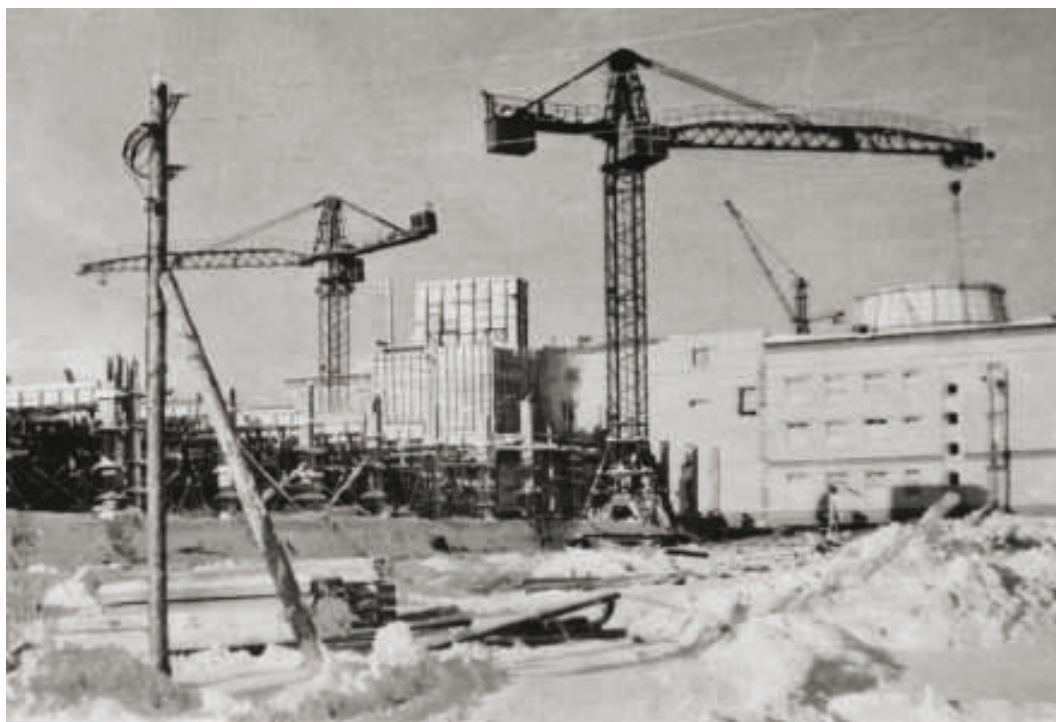
Начало строительства «горячей» части здания радиохимической лаборатории
