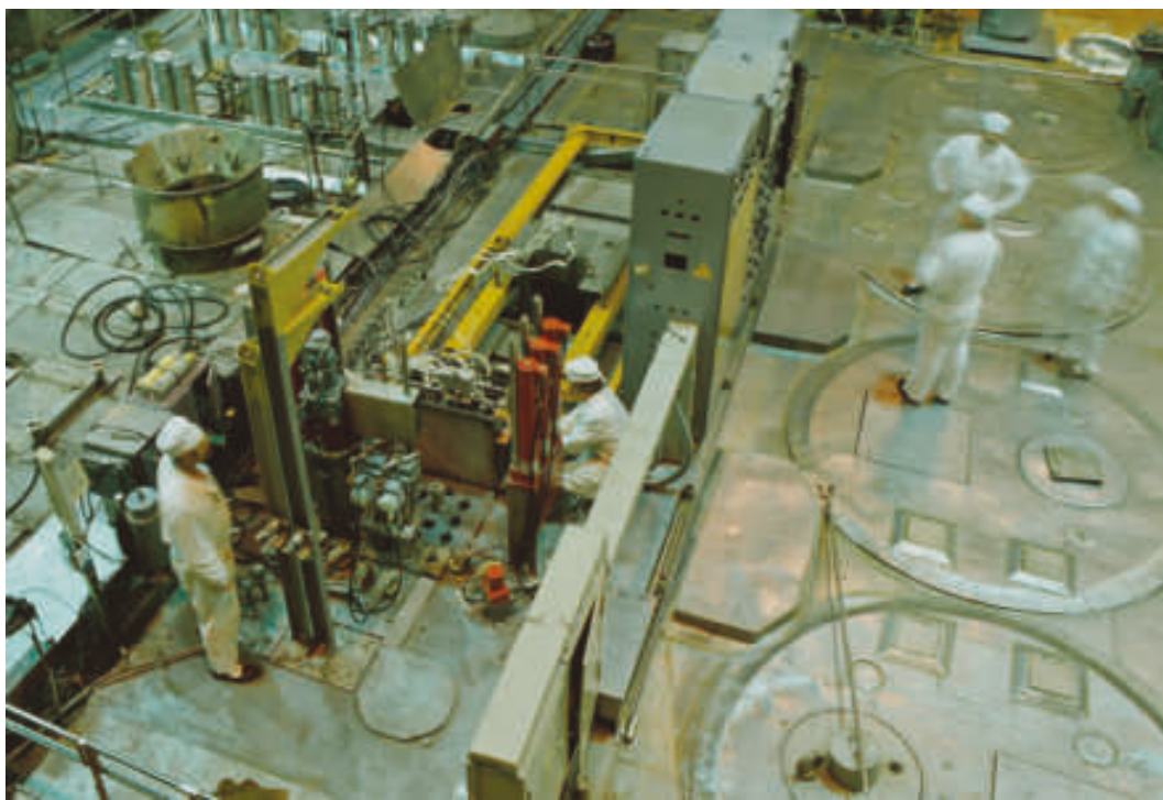
Вид сверху на реактор РБТ-6
