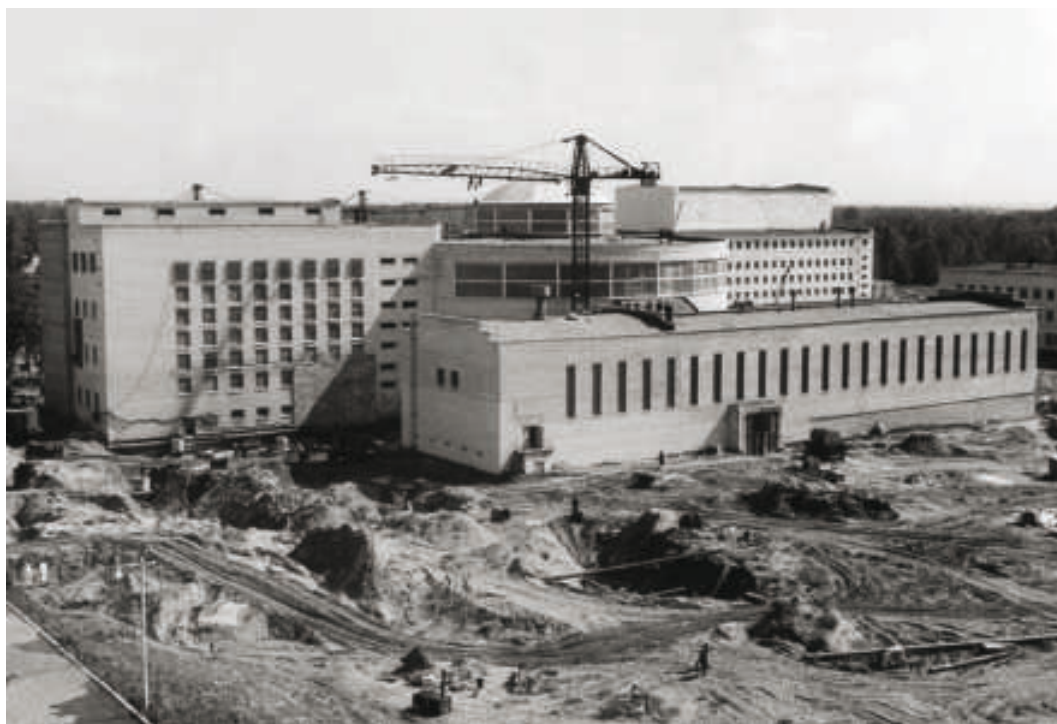
Строительство здания реакторной установки МИР
